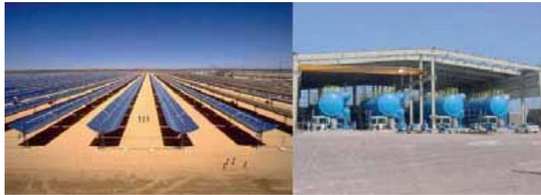
Abbildung 23: Kopplung von solarthermischem Kraftwerk (links) mit einer Meerwasserentsalzung (rechts). (Quelle: VDIIVDEIIT)
