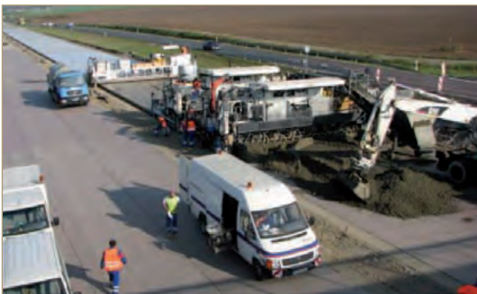
Herkömmlicher Einbau einer Betonfahrbahn mit Gleitschalungsfertiger (Foto: Eurovia Beton GmbH).
