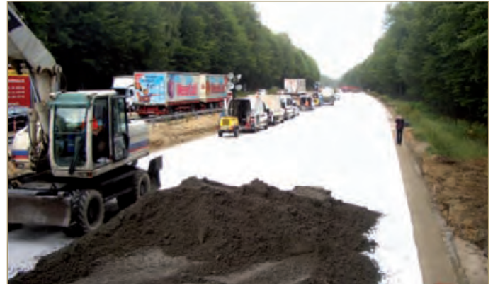
Vorbereiteter Unterbau für eine Betonfahrbahn (Foto: VDI Technologiezentrum GmbH).
